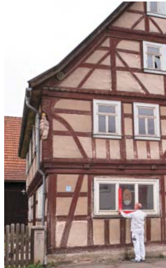
3 Stäblein positioniert die Messlatte fürs Bild-Aufmaß. Fotos: Cats Soft GmbH
