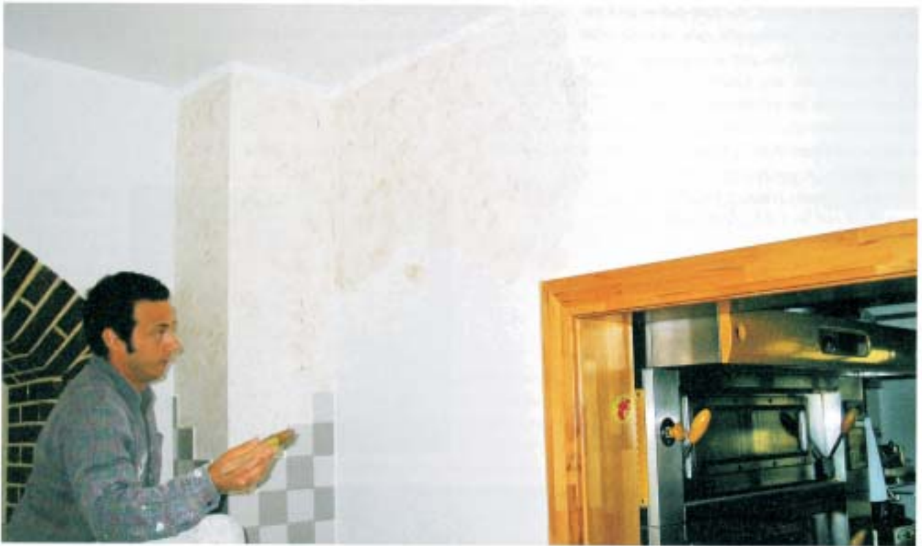
Selbst Hand anlegen: Innengestaltung für eine Pizzeria in einer dekorati- ven Lasurtechnik
